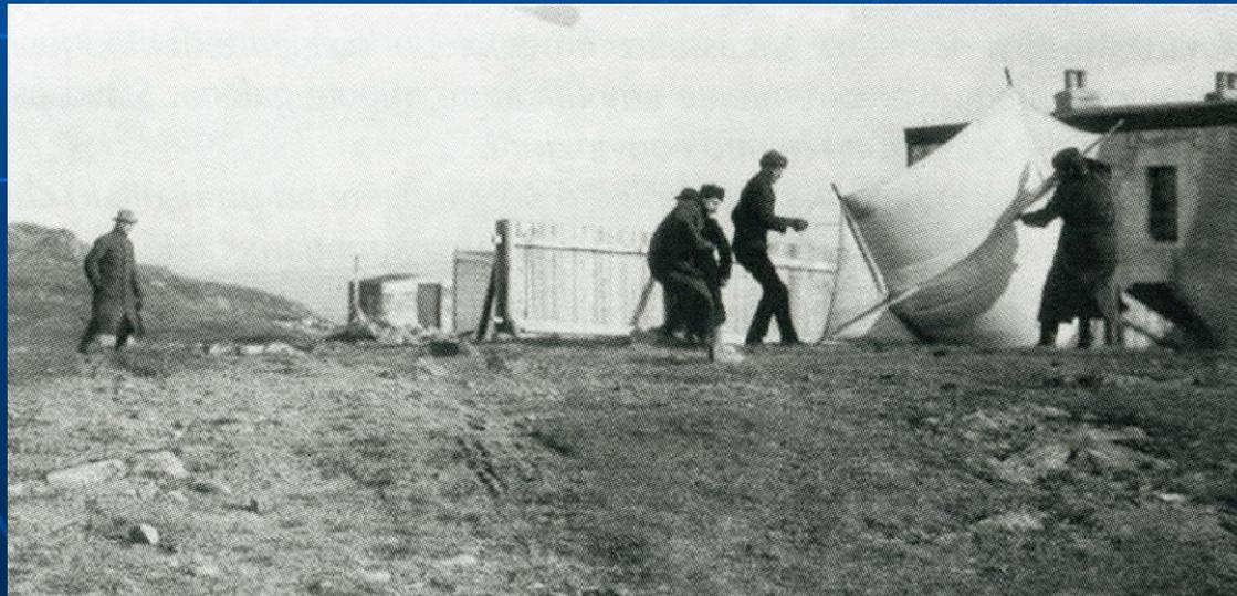
Marconi (a sinistra) e i suoi collaboratori alzano l'aquilone che sostiene l'antenna a 120 m
